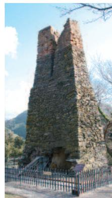
鉄製大砲の鑄造に必要な金属溶解炉。現在残っているのは煙突にあたる部分で高さは10.5m。現存するのは葦山(静岡県)と萩市の2箇所のみ。
